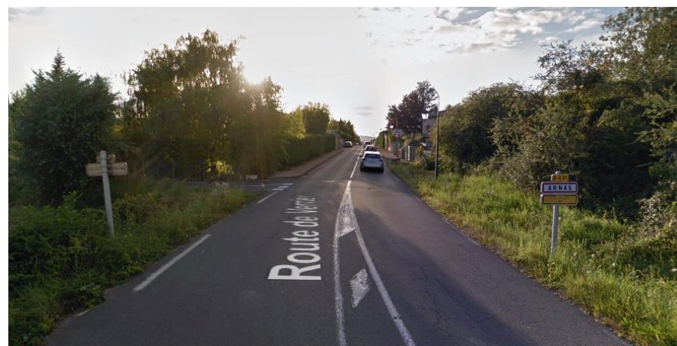
Entrée Est d'Arnas dépourvue d'identité et non marquée (Google Earth)
